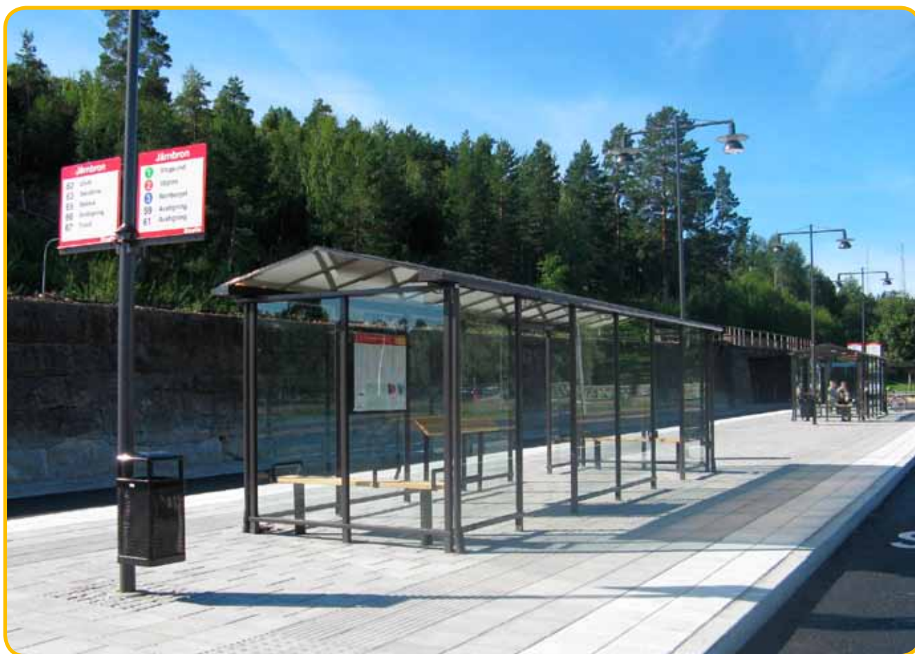
Bussomstigningsplats Södra Hamngatan
