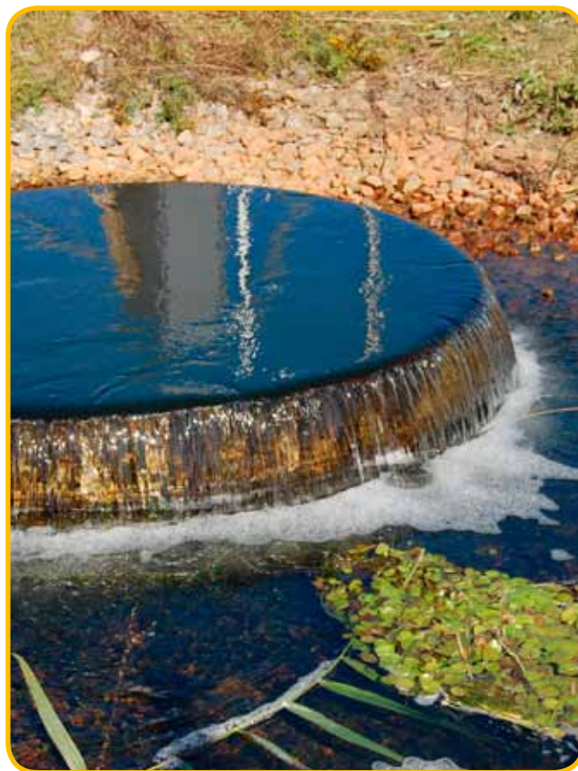
Utgående vatten vid reningsverket vid Forsbackabron
